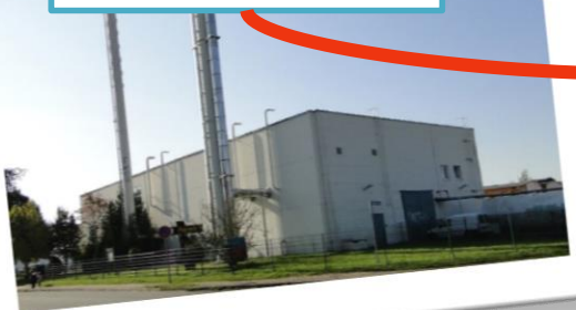
Geothermische Heizzentrale & Aquiferspeicher
